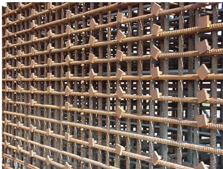
T-hodet tverrarmering i vegg til en konstruksjon for nukleært avfall
