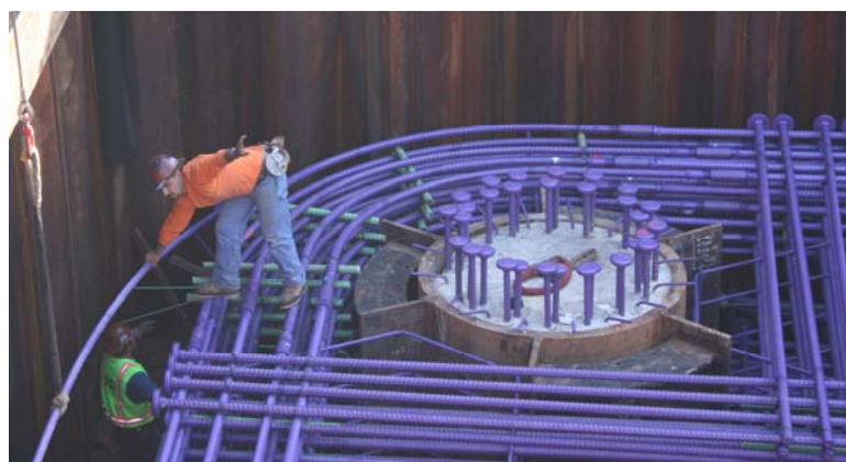
HRC 490 Posisjonskobling for bøyd armering
