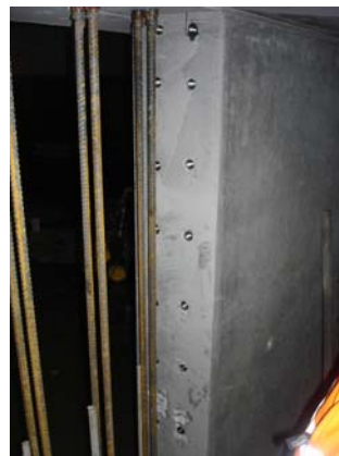
Ingen utstikkende armering – forbedret tilgang og økt sikkerhet
