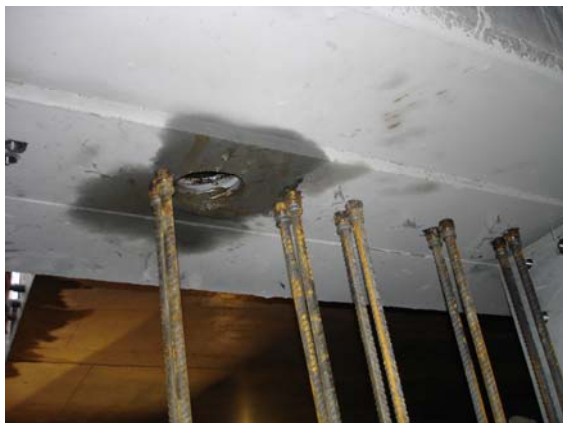
Lukking av en veggåpning for spennutstyr i etterkant
